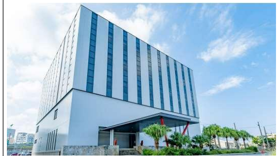
FRT iDC ビル
