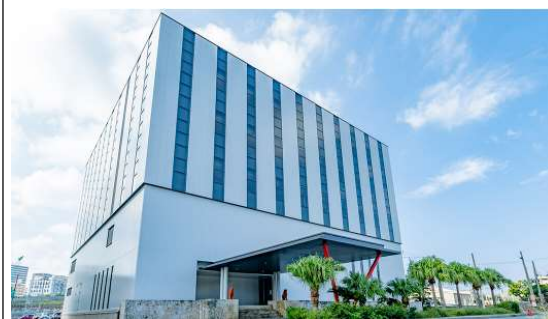
FRT iDC ビル
